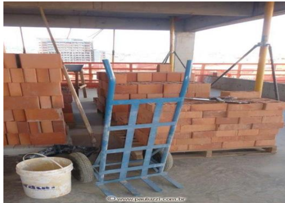
Figura 15 - Paletização dos tijolos na obra
