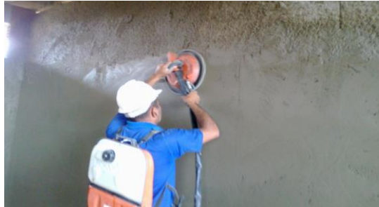
Figura 18 - Uso de equipamentos na obra
