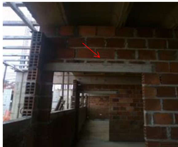
Figura 12 - Aplicação de verga pré-moldada
